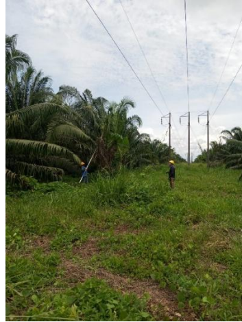
Podas de la servidumbre en los 187km de la Línea 115kV y en los 174 km de redes 34.5kV
